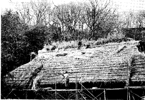
旧伊藤家の屋根葺替
