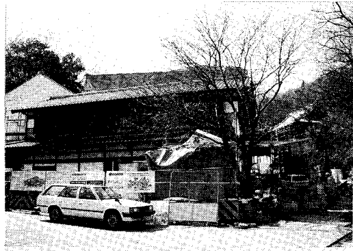
本館建設状況
